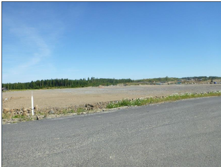
Entinen Kivimurrontien linja oli maansiirtotyömaa-aluetta. Pohjoiseen.
