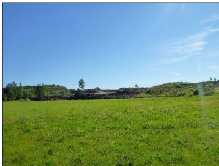
Inventointialueen maastoa Murton tilan itäpuolisella peltoalueella. Maansiirtotyöt käynnissä peltoalueen eteläpuolella.
